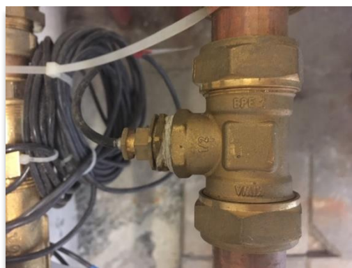
Figuur 6 - Montage in T-Stuk met adapter
